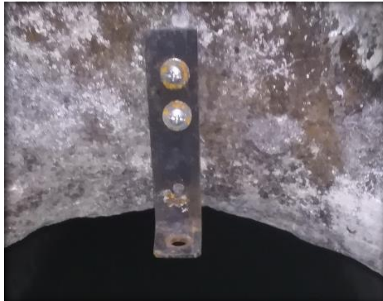
Figura 1.20: Platina estática en el pozo de revisión
