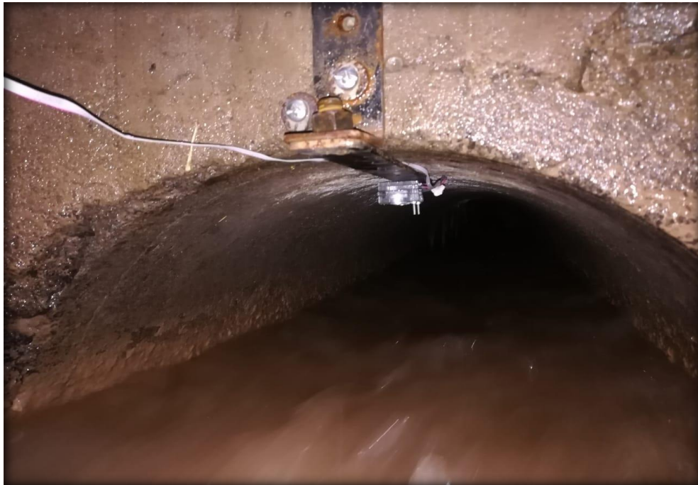
Figura 3.11: Tubería del Interceptor I
