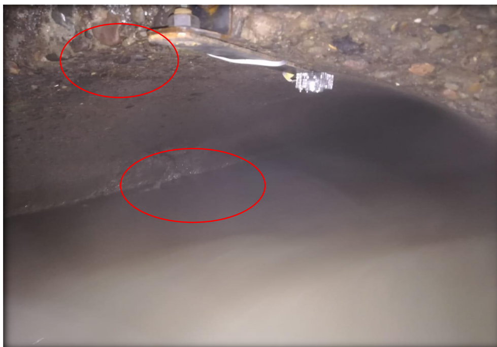
Figura 3.7: Tubería del Interceptor I
