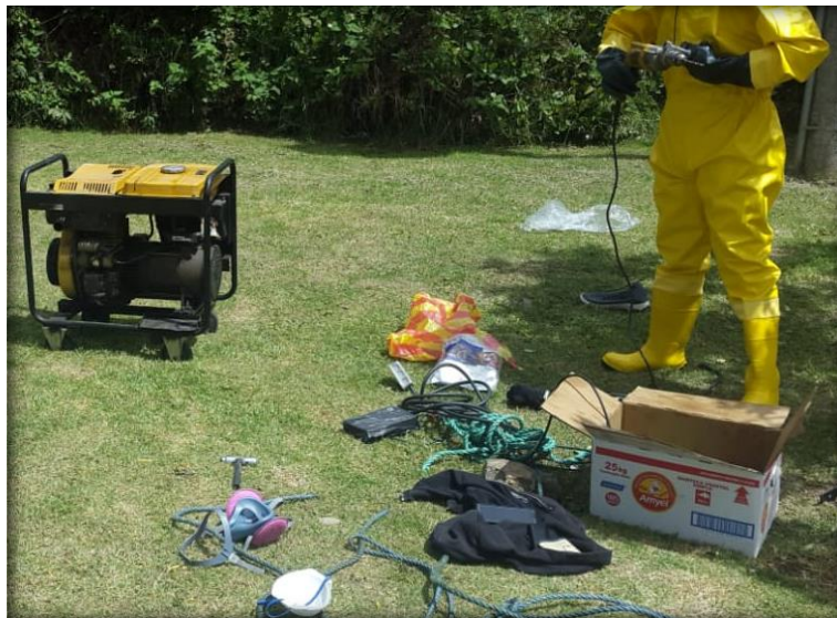
Figura 1.22: Herramientas y equipo para instalación de platinas
