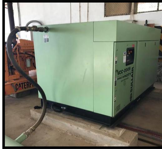
Figura 2.3 Compresor Eléctrico
