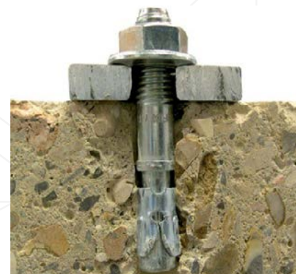
Imagen 51: Perno de anclaje
