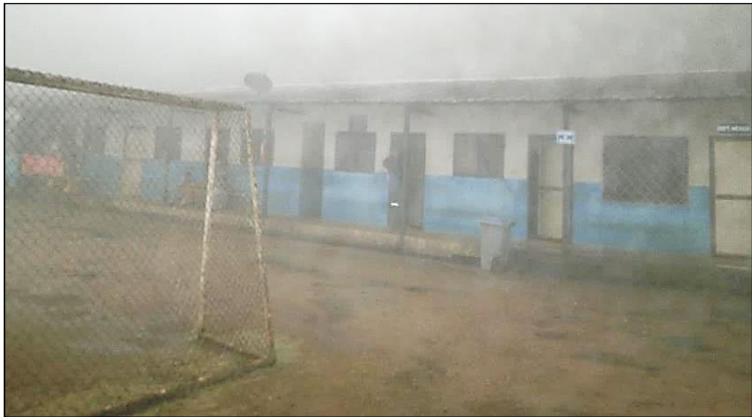
Figura 1.2 Infraestructura del campamento Minerandina Cia Ltda
