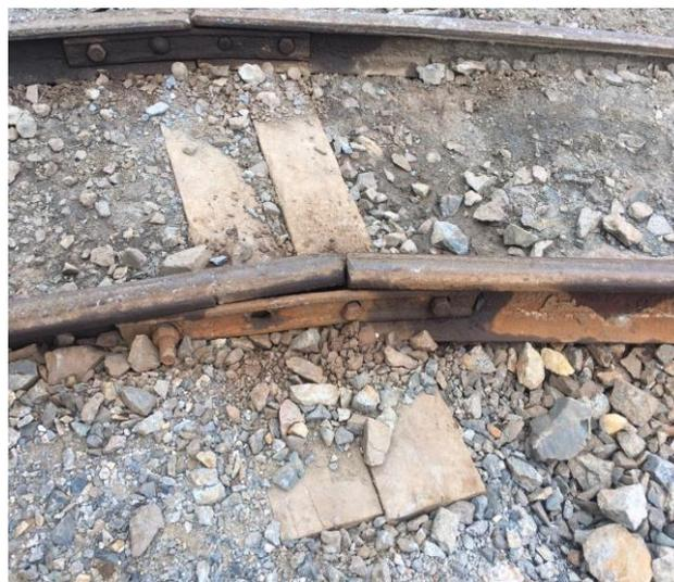
Figura 3. 11 Mal estado de pernos en el riel
