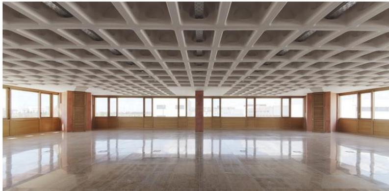
*Figura 1-23: Imagen ejemplificadora de una losa alivianada*
