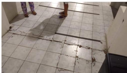
Ilustración 1-24: Daños no estructurales del sismo del 22 de febrero de 2019
