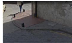
Fig. 58 Gradas formadas por rellenos o cambios de material
