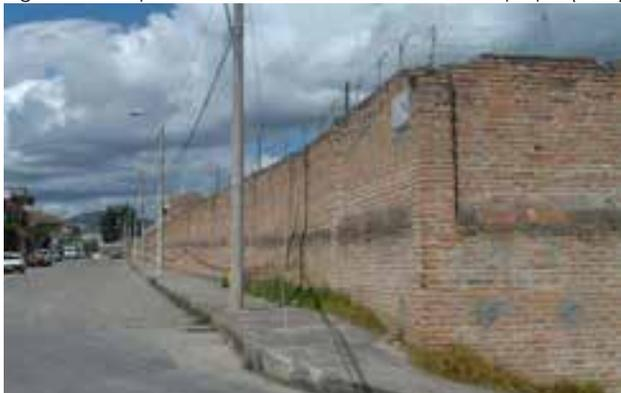
Figura 49. Cerramiento de muro de ladrillo. Ochoa (2006)
