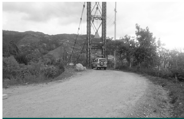
Imagen 38. Vía de tierra entrada al puente Fuente: Elaboración propia
