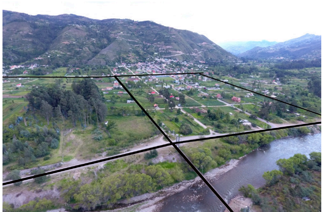
Imagen 44. Vías rehabilitadas Fuente: Elaboración propia
