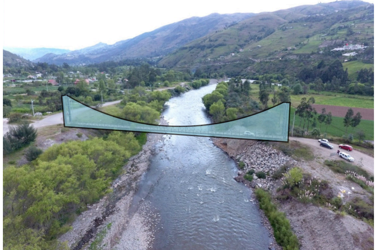
Imagen 36. Zona de puente planteado Fuente: Elaboración propia
