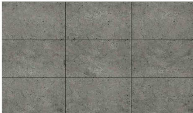
Las Placas de fibrocemento de 240 x 120 cm, se colocan de forma horizontal y se emplean para las fachadas exteriores y para las principales paredes internas de los bloques, este material es de rápida instalación y tiene buena resistencia a las condiciones climáticas del cantón.
