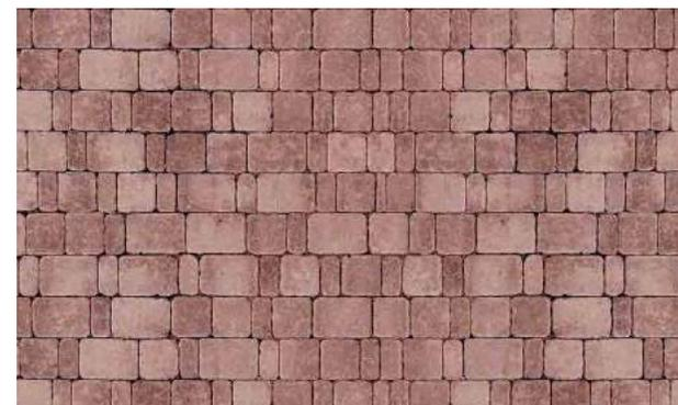
Este adoquín de concreto tinturado con una tonalidad rojiza, se emplea en las plazas orgánicas del proyecto para marcar las zonas de estar, este material es antideslizante y de una fácil aplicación.
