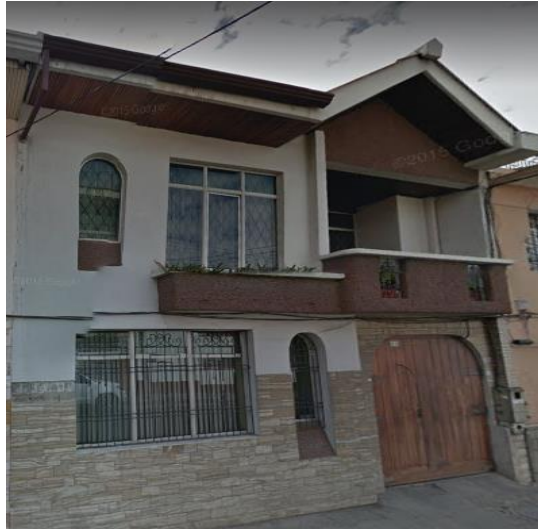
Figura 2.3 Vista frontal de la vivienda mediana. Elaboración: Autores.
