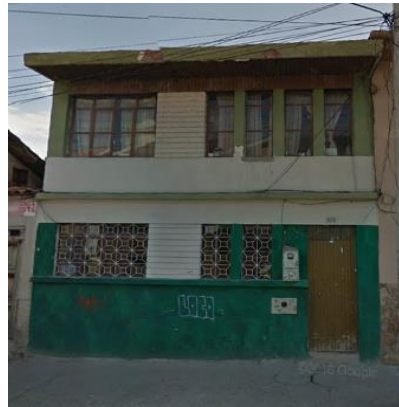
Figura 2.1 Vista frontal de la vivienda pequeña.
