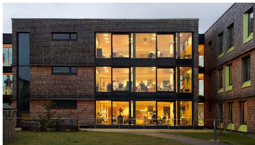
Ilustración 52. Vista frontal del asilo
