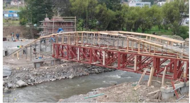
Figura 1. Trabajo reciente del Taller de Mecánica Industrial JV: Construcción y Montaje de una Cercha Metálica para un Puente en la ciudad de Azogues.
