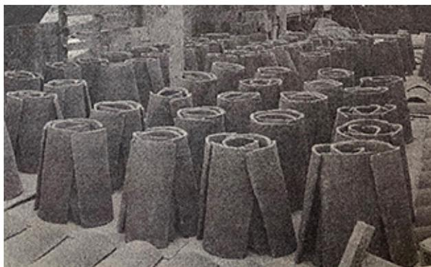
**Imagen 9: Galpón para secado de tejas**
