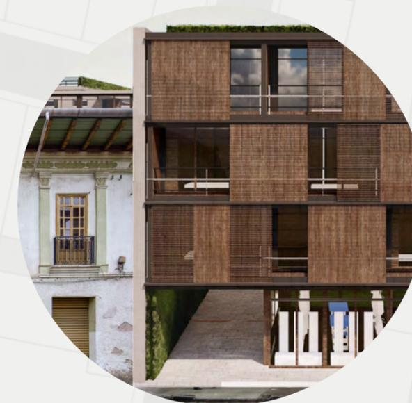
La vivienda se construye con paneles prefabricados verticales y horizontales adaptables a la obra nueva y la obra preexistente. En caso de obra nueva se ensamblan en una estructura principal metálica y en caso de obra actual en las columnas y vigas de hormigón.
