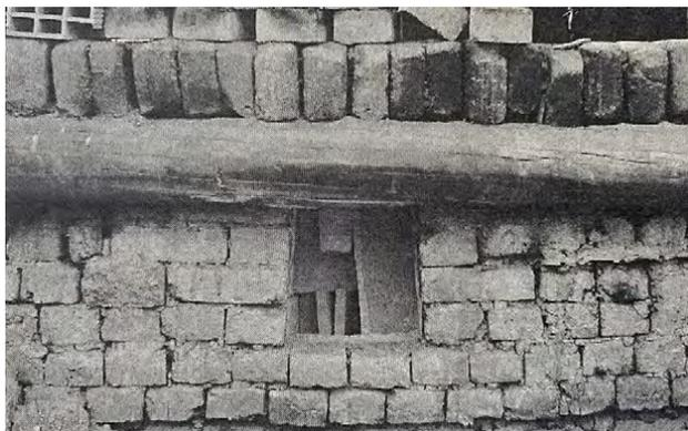
**Imagen 10: Horno para cocción de ladrillos**
