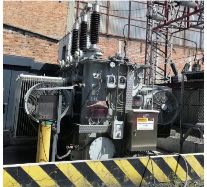
Figura 5. Transformador de Potencia 12.5 MVA
