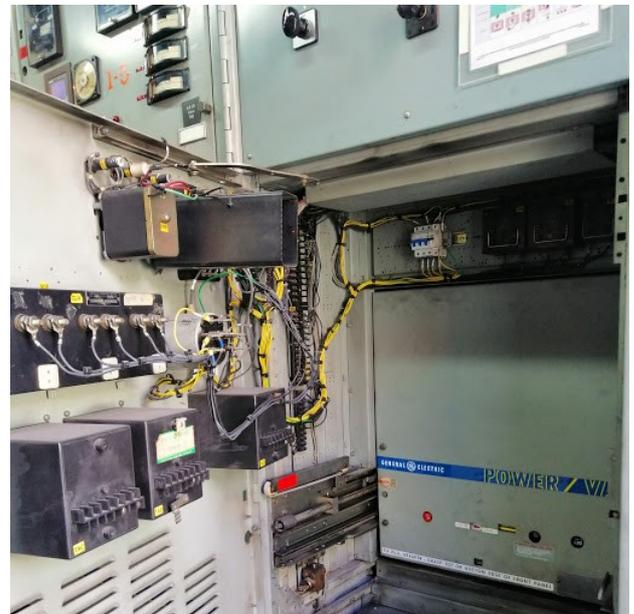
Figura 6. Interruptor de Potencia 1200/3000 A
